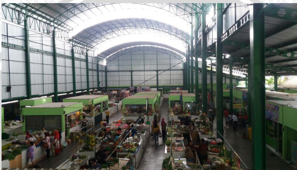
Gambar 3 Kondisi Bangunan Pasar Oro-oro Dowo Setelah Revitalisasi Sesuai Persyaratan Keamanan dan Kenyamanan
