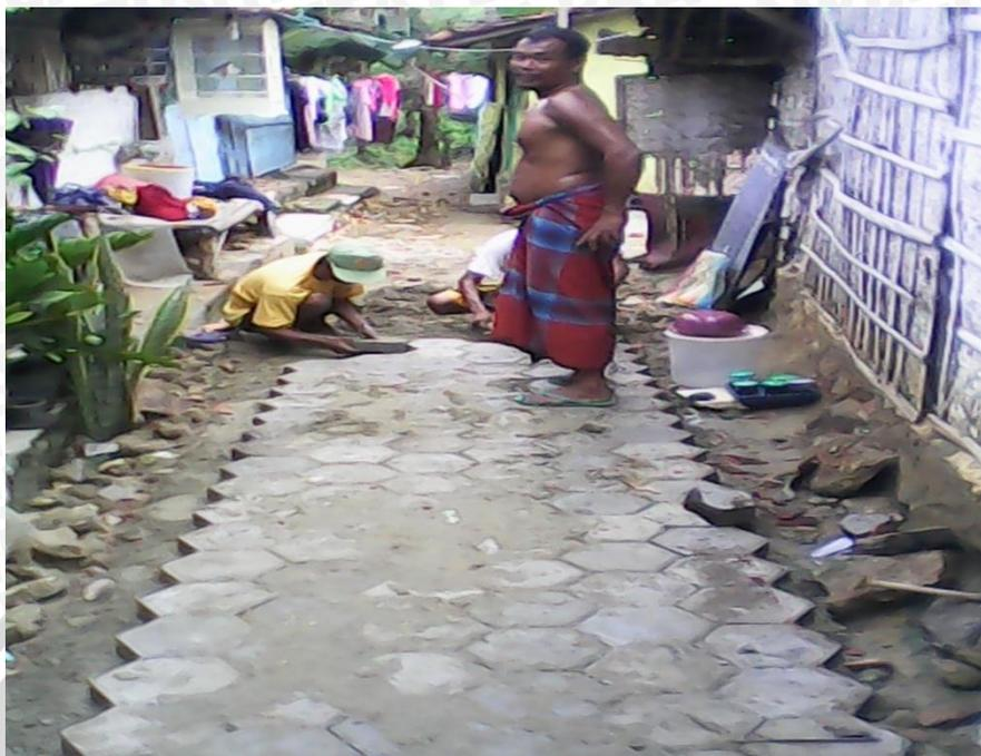
**Gambar 9 : Pemasangan *paving block* oleh warga kelurahan Parteker**
