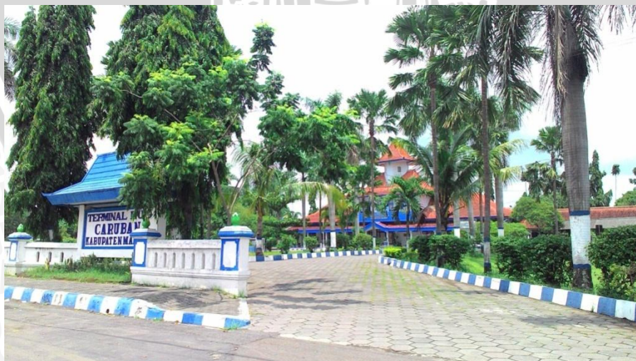
Gambar 11 : Terminal Bus Caruban Kabupaten Madiun
