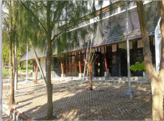
Gambar 1.14 Bangunan Tourist Information Center (TIC) di Paltuding TWA Kawah Ijen
