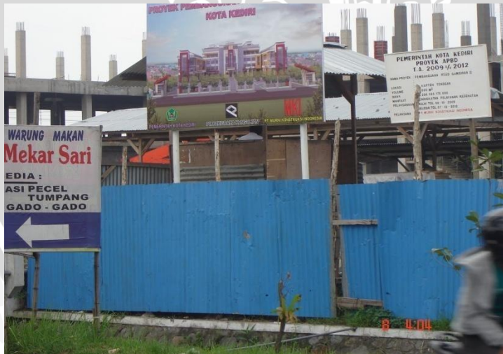
Gambar 2 : Pembangunan di area Sutet
