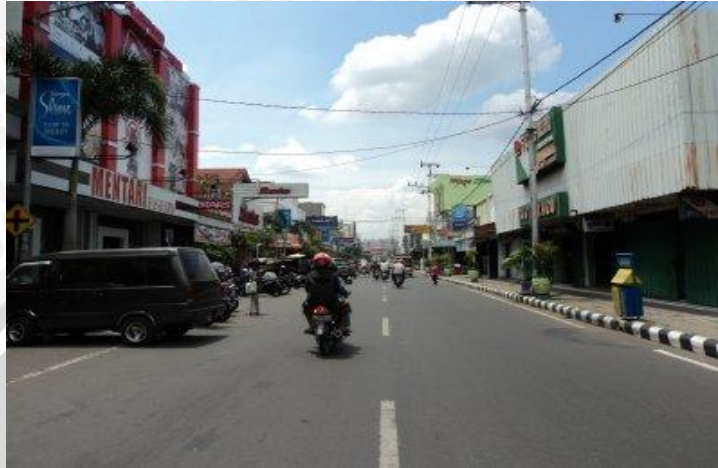
Gambar 1 : Jalan Doho yang IMBnya tidak sesuai dengan GSB
