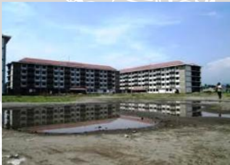
Gambar 4 : Rusunawa yang belum dijalankan sesuai fungsi bangunan
