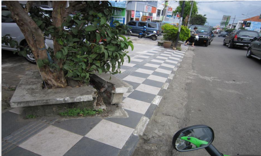
Gambar. 4.5 Pembangunan Trotoar yang Kurang Nyaman Terlihat dari Tidak Adanya Pembatas dan Sama Ratanya Antara Trotoar Dengan Jalan
