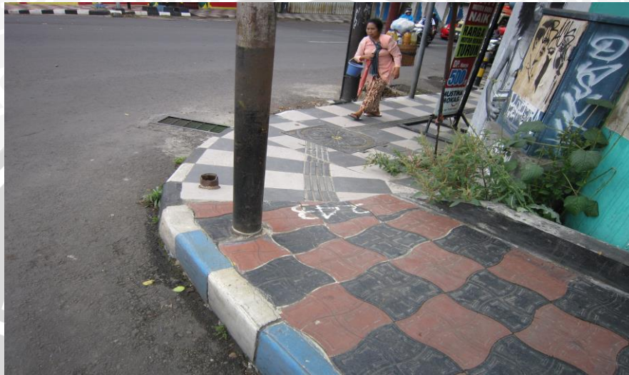
Gambar. 4. 3 Pembangunan Trotoar Bagi Difabel: Desain Tahun 2012 (Merah-Hitam) dan Tahun 2013 (Hitam-Putih)
