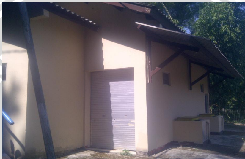
Gambar 15. Rumah Pembangkit ( Power House )
