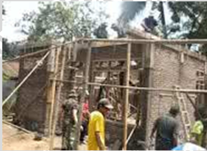
Gambar 7 Pembangunan Rehab Rumah Warga Desa Ngadirengga Tahun 2011
