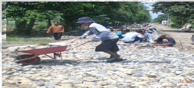
Gambar 3 Pembangunan Makadam Jalan Desa Ngadirengga Tahun 2011
