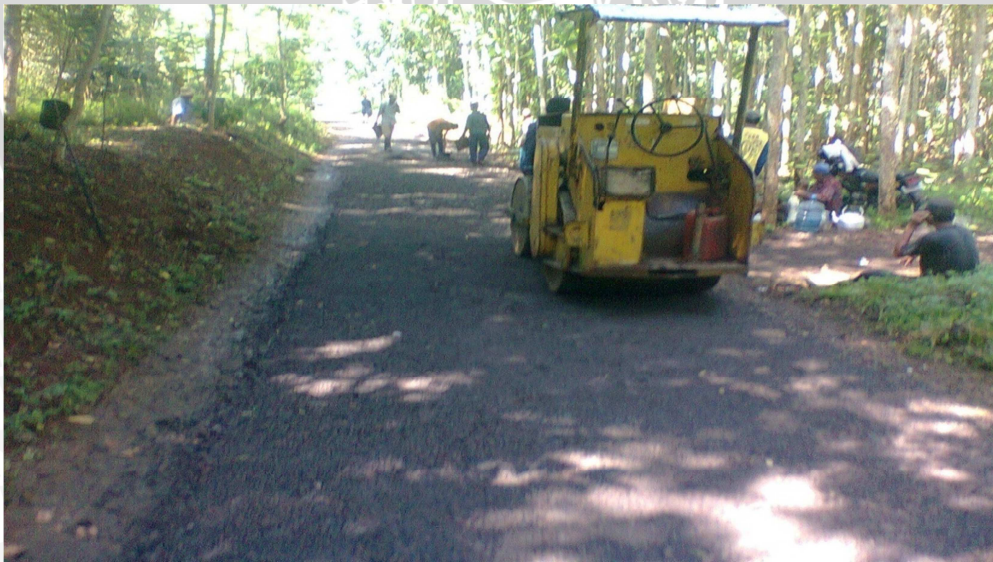
Gambar 2 Pembangunan Aspal Jalan Desa Ngadirengga Kecamatan Wlingi Tahun 2011
