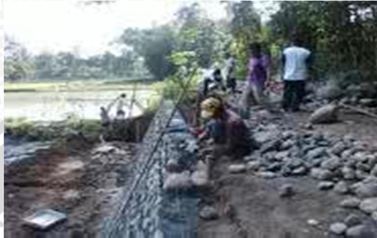
Gambar 5 Pembangunan Plengsengan Desa Ngadirengga Tahun 2011
