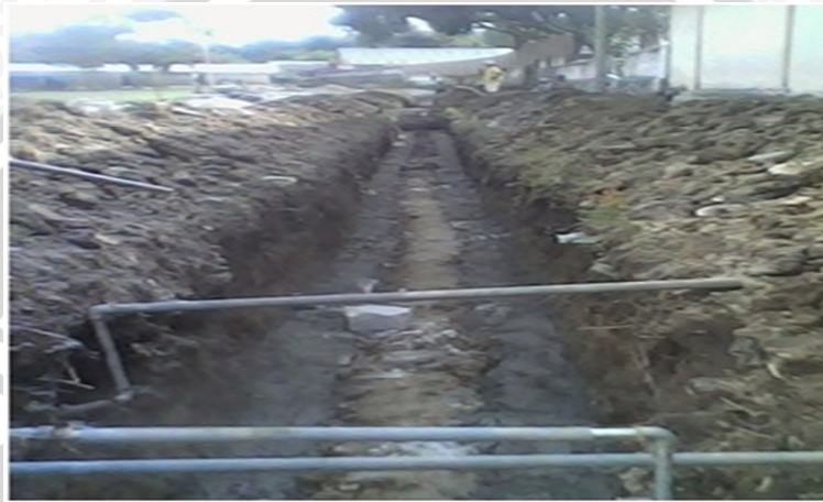
Gambar 6 Pembangunan Parit/ Drainase Desa Ngadirengga Tahun 2011
