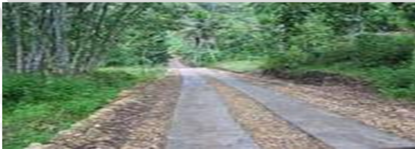
Gambar 4 Pembangunan Rabat Jalan Desa Ngadirengga Tahun 2011
