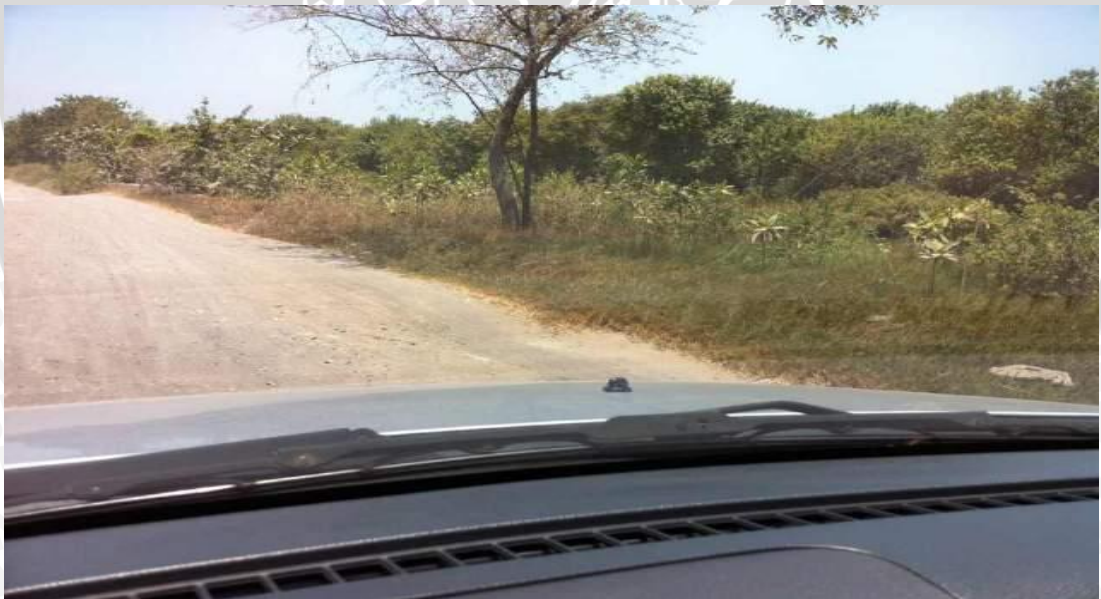
Kondisi jalan menuju ekowisata mangrove Wonorejo yang rusak dan sempit
