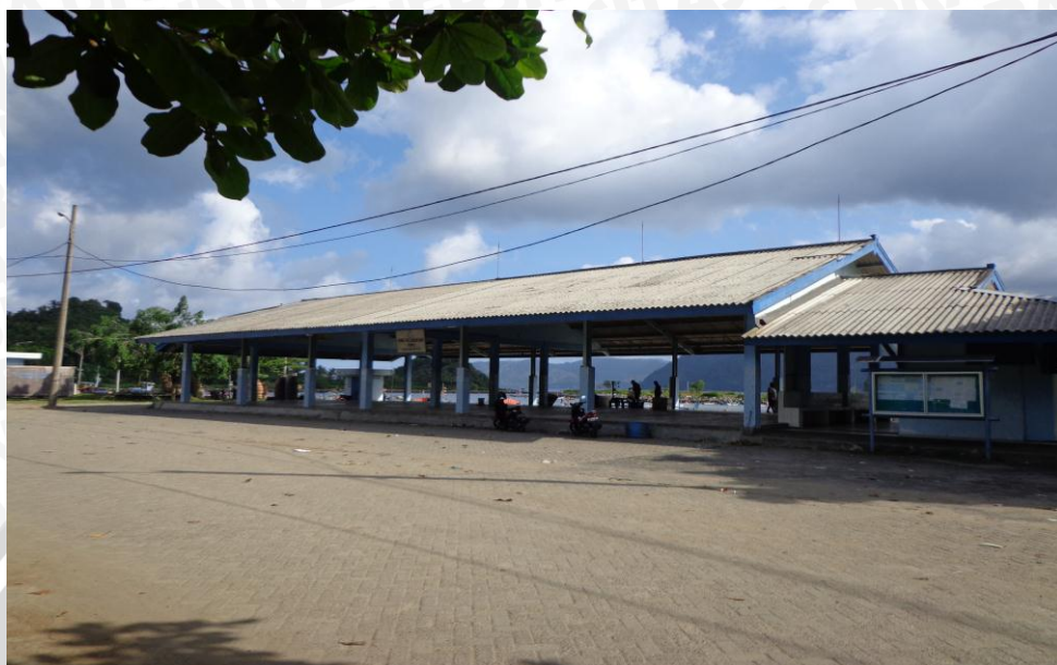
Gedung Tempat Pelelangan Ikan Barat
