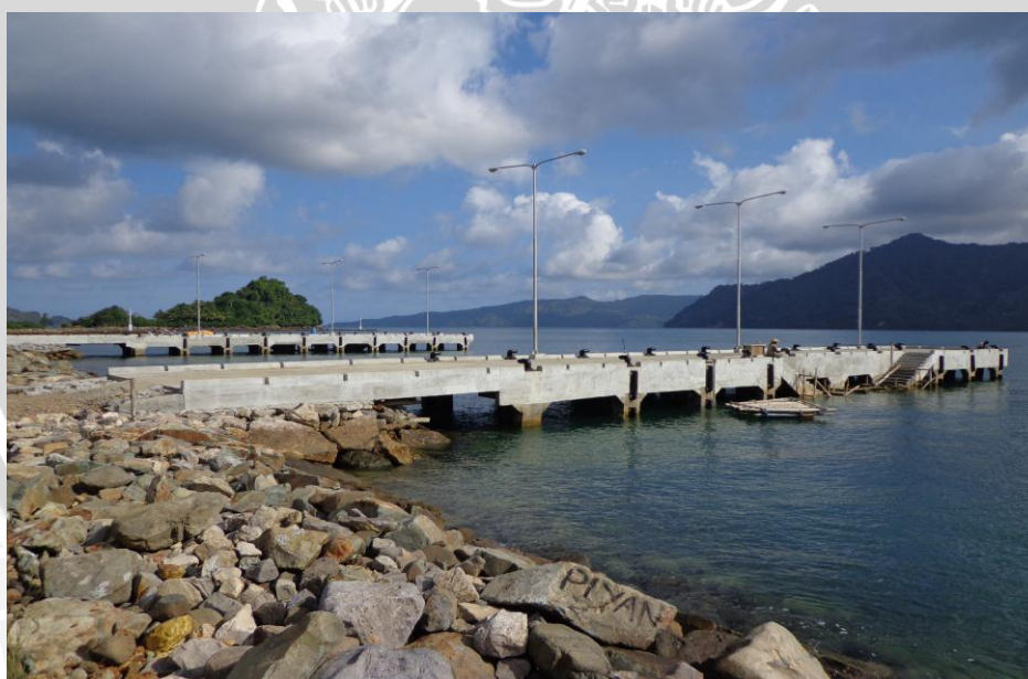
Jembatan Jetty untuk Kapal 30 GT
