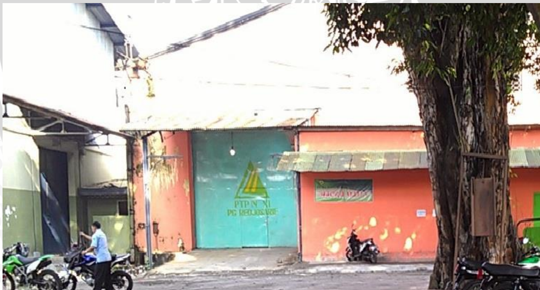
Gedung operasional penggilingan tebu
