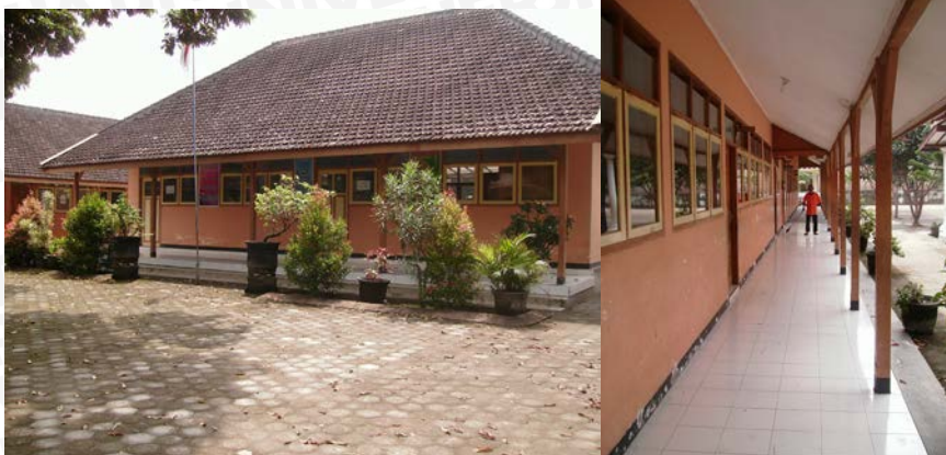
Keterangan: Keadaan Bangunan Kantor dan lorong kelas-kelas SD Negeri II Ngadiluwih diambil pada tanggal 10 Maret 2012
