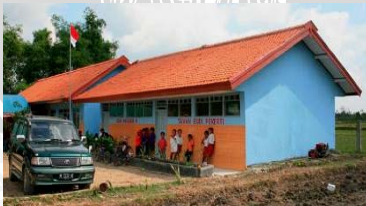
Gambar 8. Renovasi Gedung Sekolah
