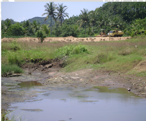
Pembangunan jalur Lintas Selatan
