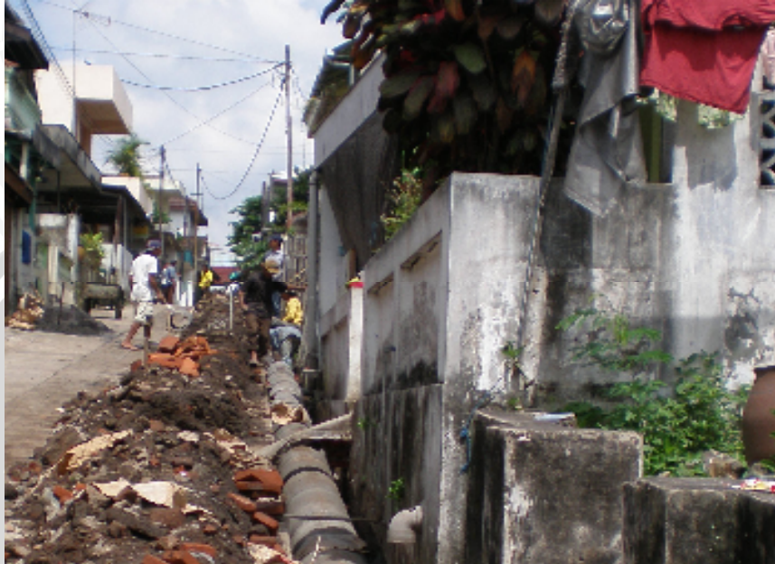
Gambar 6 Pembuatan Jalan Dan Gorong-Gorong Merupakan Kegiatan PNPM Pada Sektor Pembangunan Sarana Lingkungan
