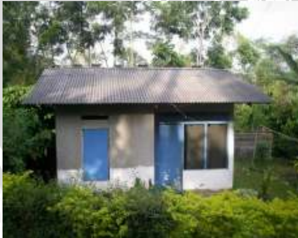
Resettlement (rumah type 21) yang masih asli
