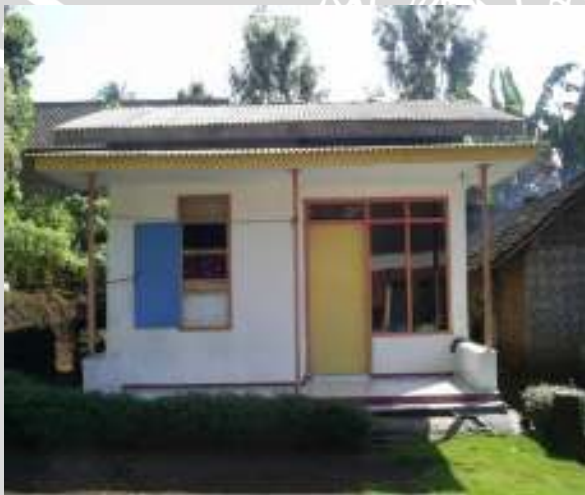
Resletment yang telah mengalami pengembangan
