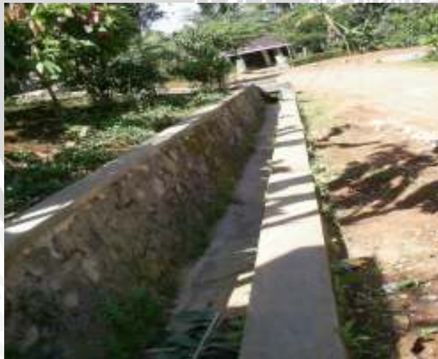
Plengsengan jalan Desa Ringin Kembar
