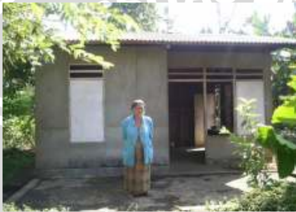
Resettlement (rumah type 21) yang masih asli
