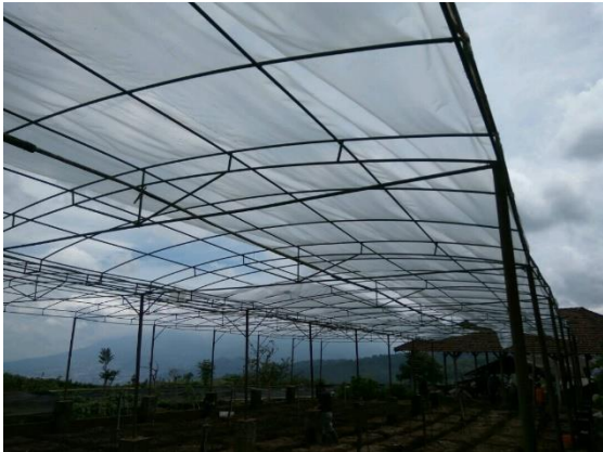
Pemasangan Screen (21 Maret 2017)
