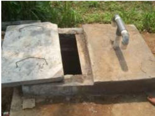
Gambar 6. Bendungan atau Rorak yang berfungsi sebagai alat penampung air.
