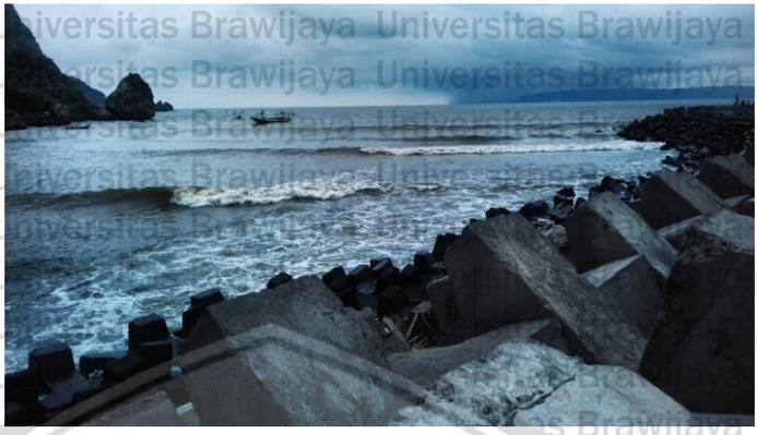
Gambar 8 Kondisi Plawangan dengan Break Water yang Telah Diperbaiki (Sumber : Dokumentasi Pribadi)
