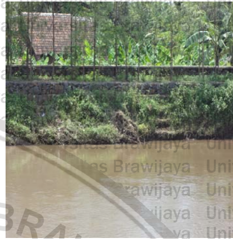
Kondisi yang sudah dipondasi
