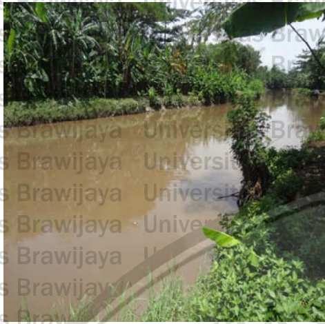
Kondisi yang belum dipondasi
